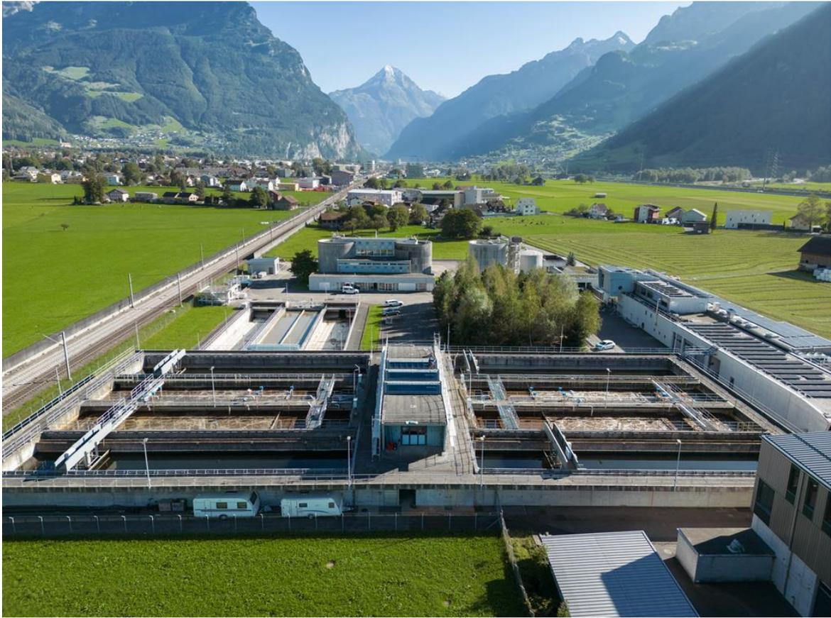
Die ARA Altdorf weist zunehmend Sanierungsbedarf auf und muss mit der gesetzlich geforderten vierten Reinigungsstufe ergänzt werden.
