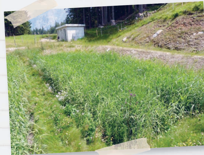
Vorklärbecken mit Schilfbewuchs – im Hintergrund das Betriebsgebäude mit Beschickungspumpe.
