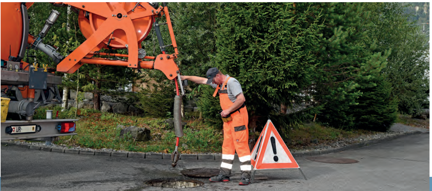
Mit Hilfe eines Saug- und Spülfahrzeugs werden die Leitungen regelmässig gereinigt.
