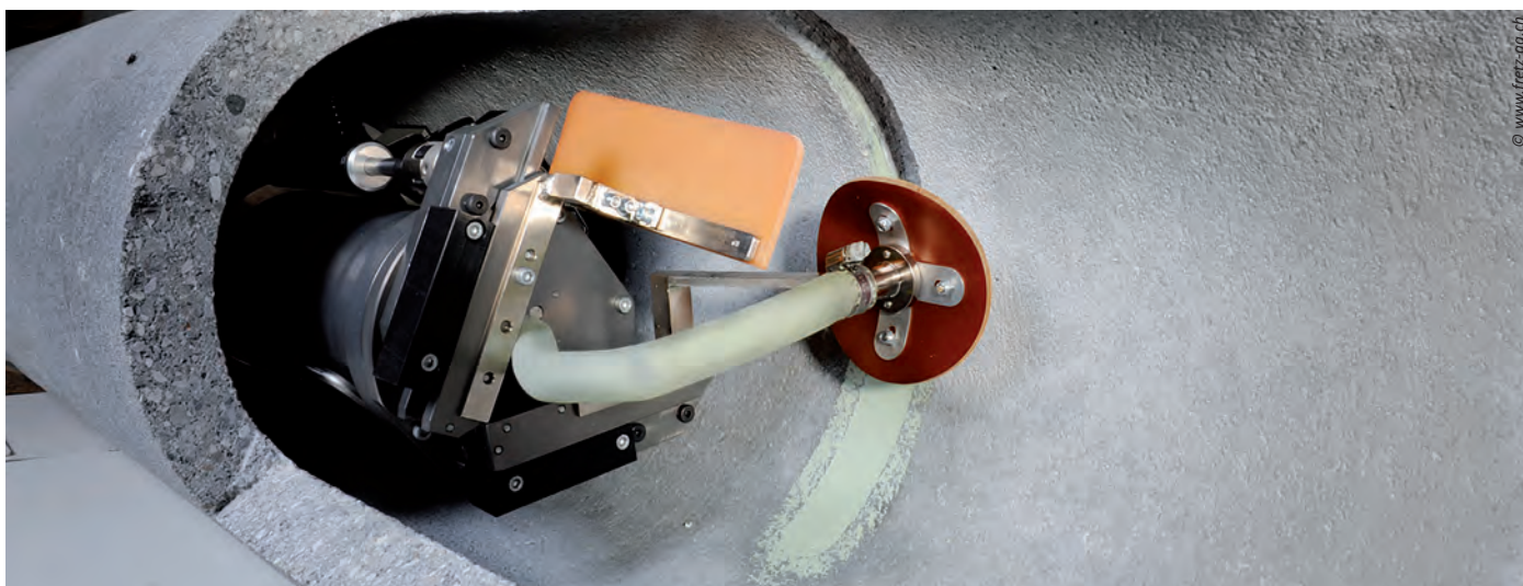
Der Roboter auf seiner Fahrt durch das alte Rohr.
